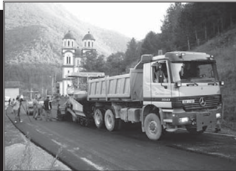
Околина цркве: Асфалтирање прилазног пута
