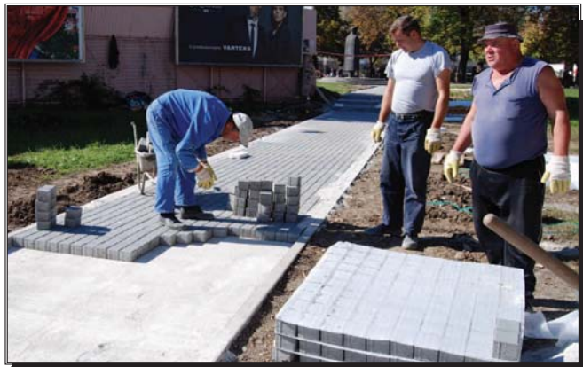
Радници „Геокопа“: Постављају бетонске плоче
