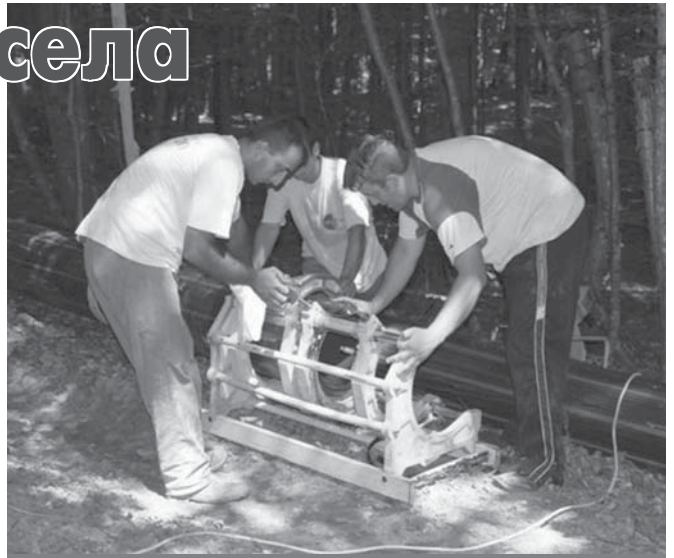
Изворште Повелич: Љетос почело постављање водоводне мреже
