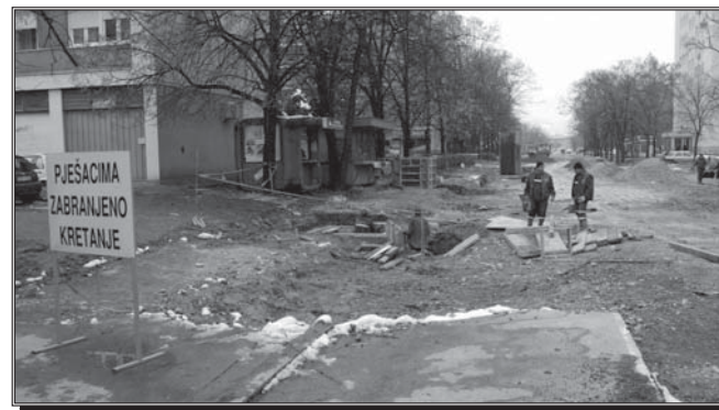
Радови на Булевару: Постављена водоводна и електро-мрежа (Снимила С. ИЛИЋ)
