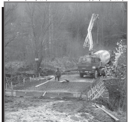
Бетонирање моста у Обравињу: Хоће ли овај пут одољети бујици?
