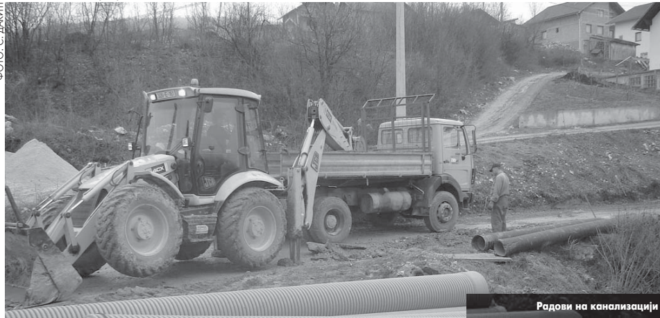
Радови на канализацији
