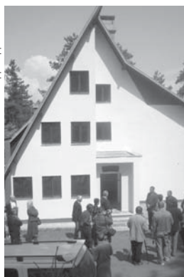
ФОТО: Д. ТОДОРОВИЋ
