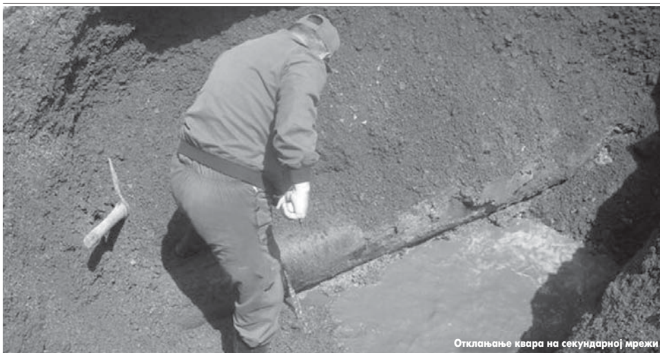
Отклањање квара на секундарној мрежи
