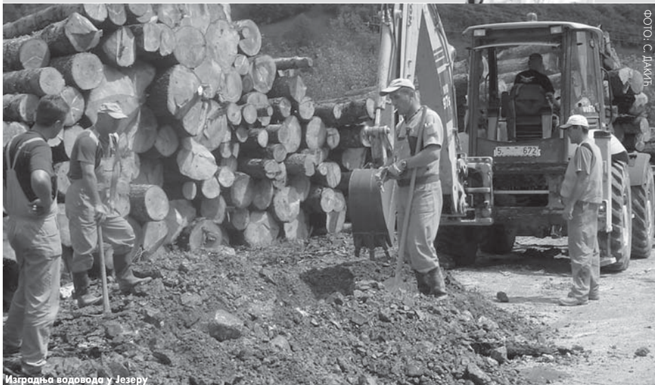
Изградња водовода у Језеру
