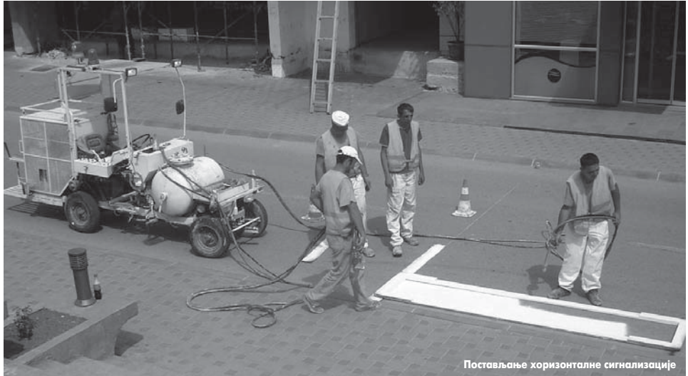
Постављање хоризонталне сигнализације
