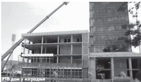
РТВ дом у изградњи
