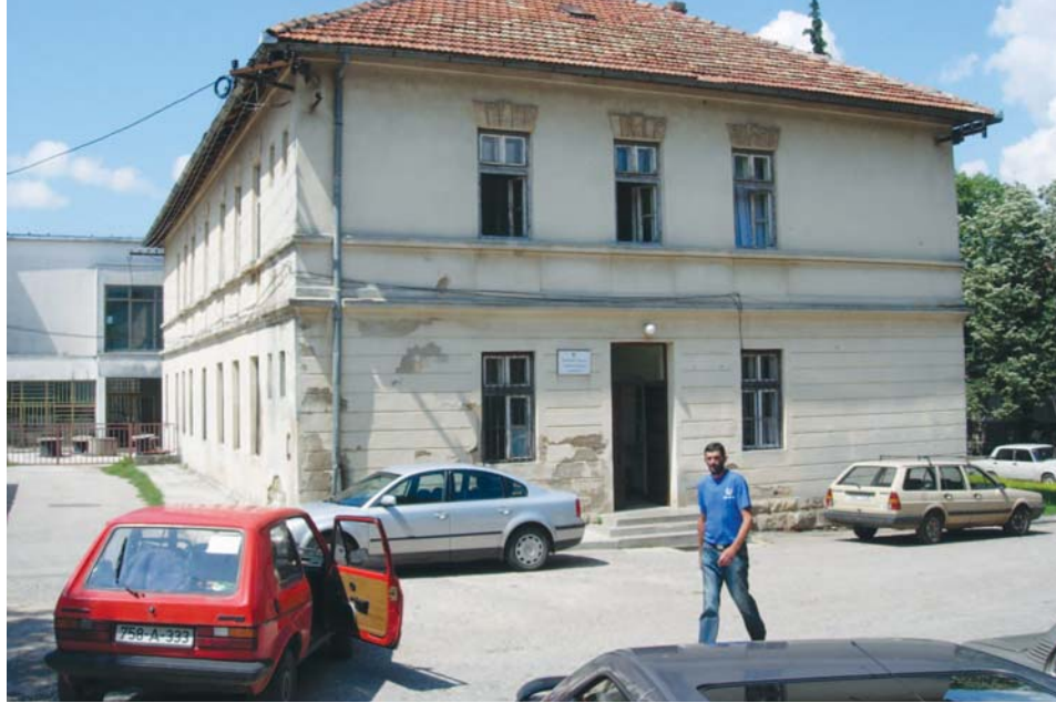
Зграда општине у Билећи изграђена прије 100 година
