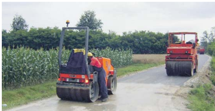
Асфалтирање пута у Арсићима
