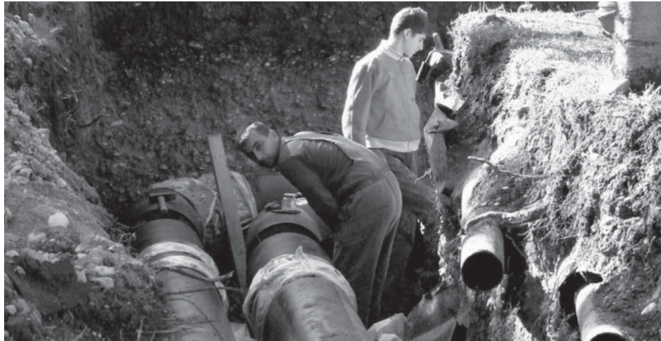
Реконструкција топловодних цијеви
