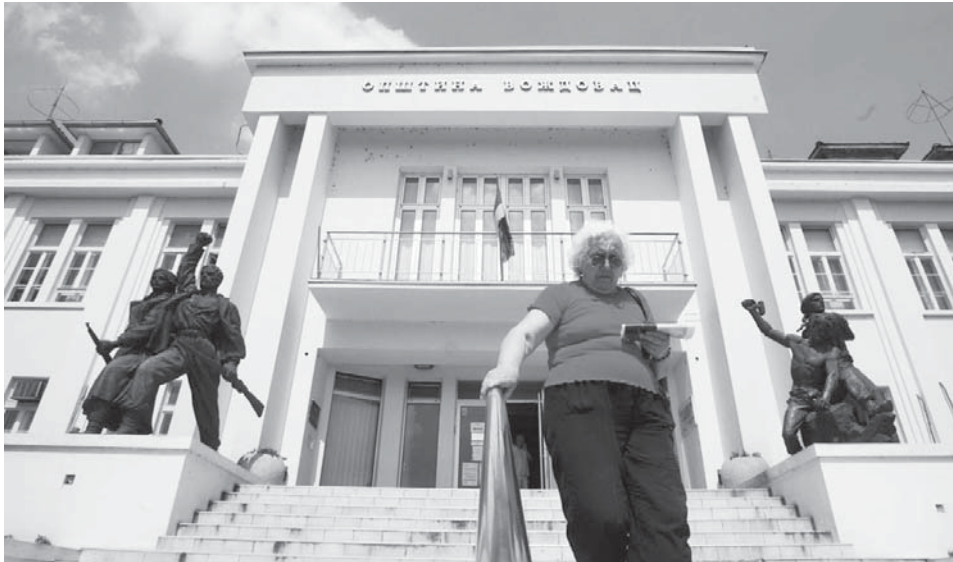
Зграда Општине Вождовац
