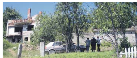
Порушене куће у Крњићима
