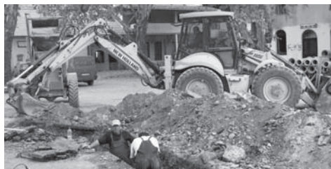
Изградња канализације у Котор Варошу
