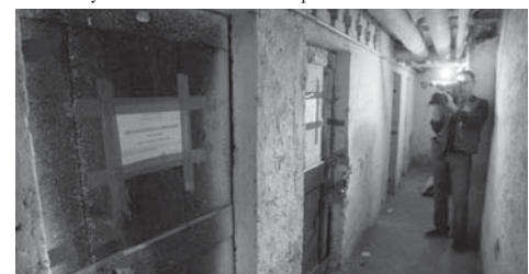
Подрум у ком је пронађен експлозив
