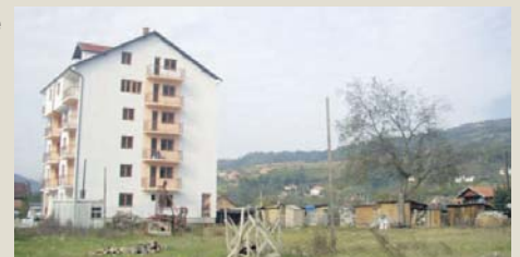
Локација за изградњу борачке зграде
