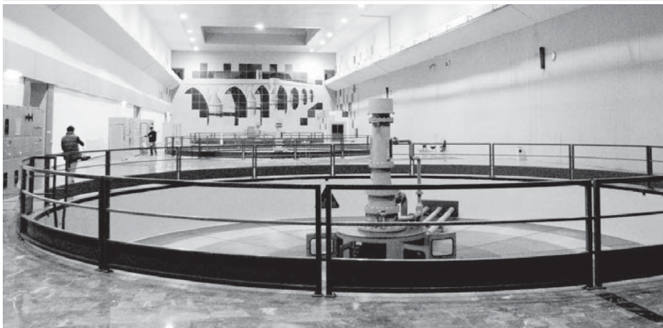
Завршен ремонт турбине ХЕ "Вишеград"
