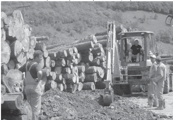
Изградња трајала четири мјесеца
