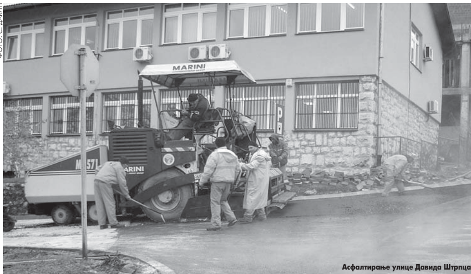
Асфалтирање улице Давида Штрпца
