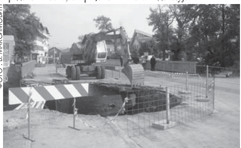
Радови на мосту у Челинцу
