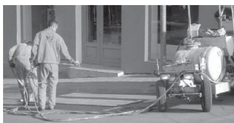
Постављање хоризонталне сигнализације
