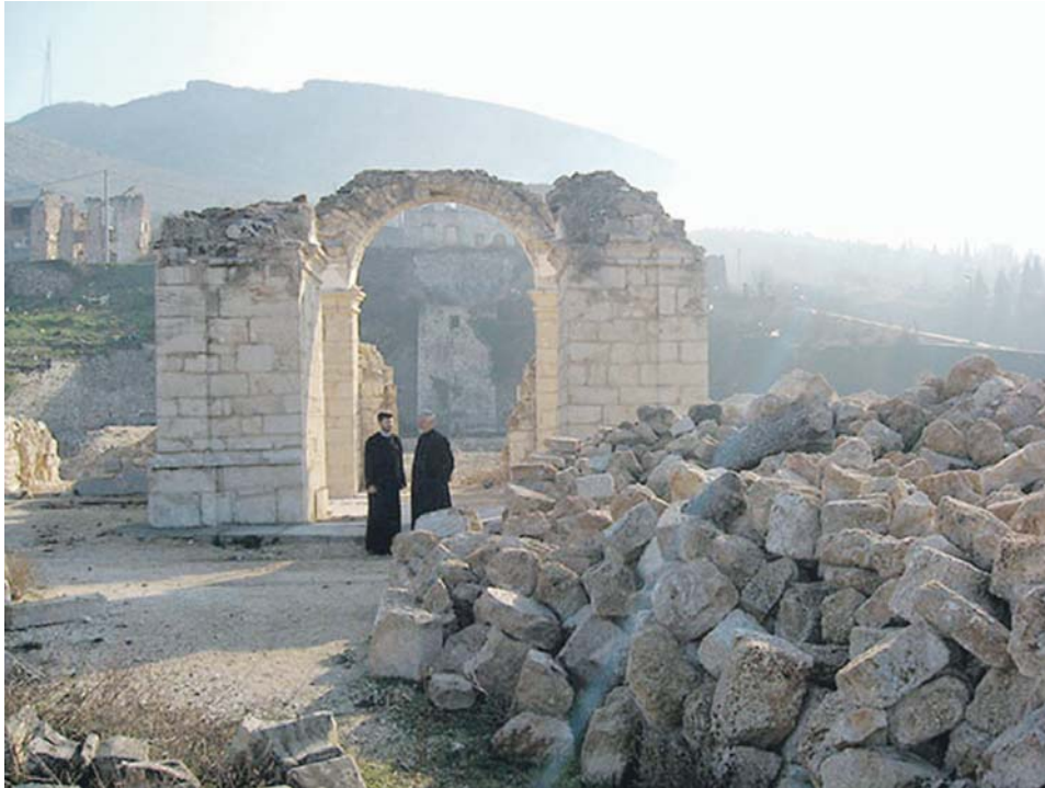
Порушена Саборна црква у Мостару
