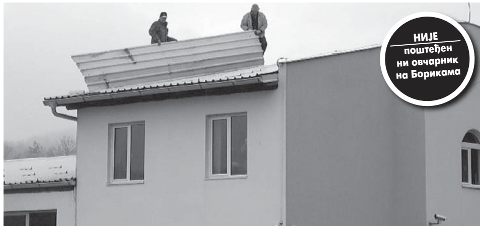
Поправљање крова на објекту "Иконић-комерца"
