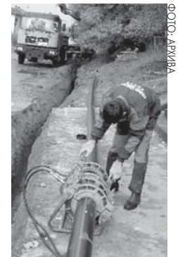
Поправљање водоводне цијеви
