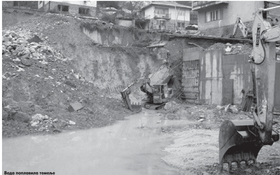
Вода поплавила темеље
