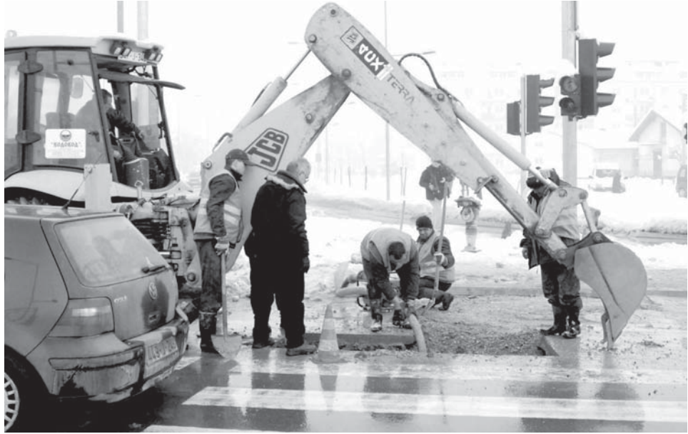
Замјена водоводне цијеве у бањолучком насељу Лазарево
