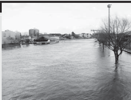
Водостај Сане у наглом порасту
