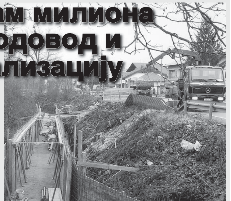
Изградња секундарне канализације у Доњем варошу
