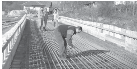
Армирање на мосту
