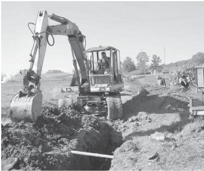
Радници отклањају квар на водоводној мрежи
