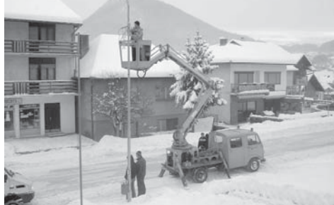
Електричари отклањају квар
