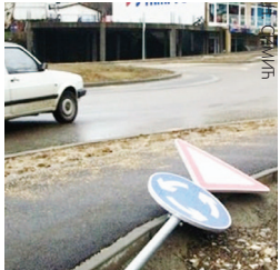
Порушени знакови у Дервенти
