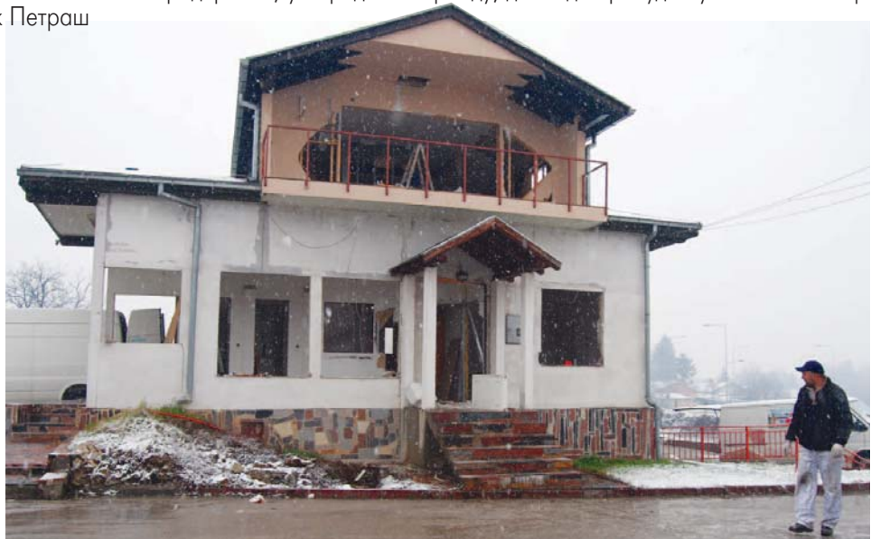
У току уклањање нелегално изграђеног објекта
