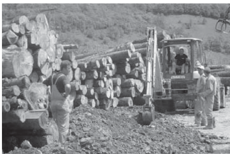
Изградња водоводне мреже
