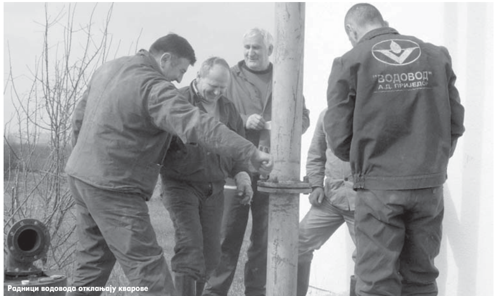
Радници водовода отклањају кварове
