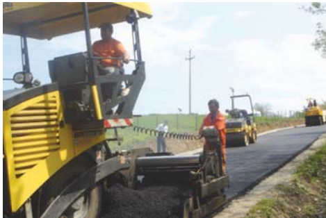
Асфалтирање пута кроз Лишњу
