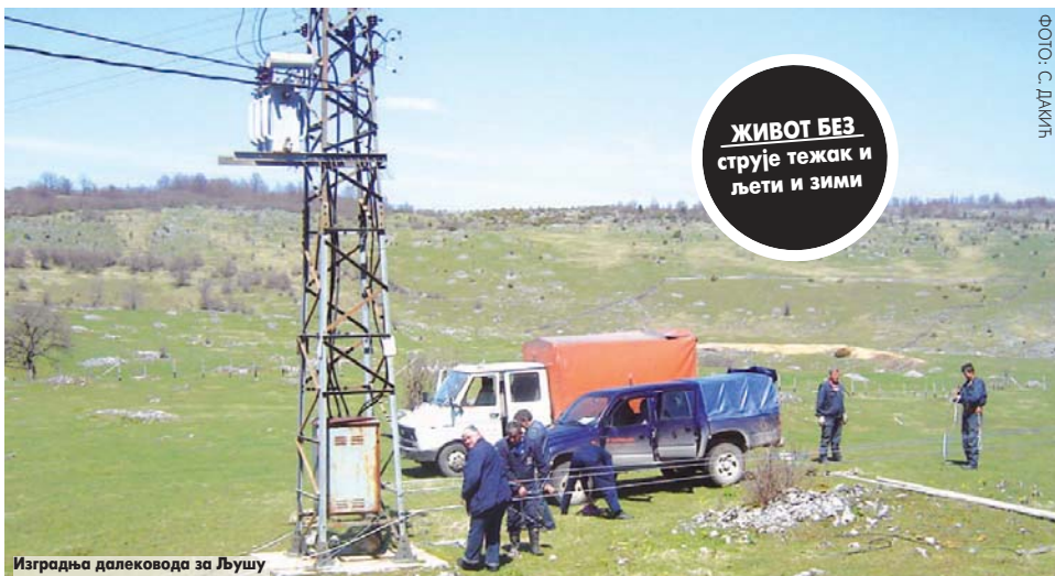
Изградња далековода за Љушу
