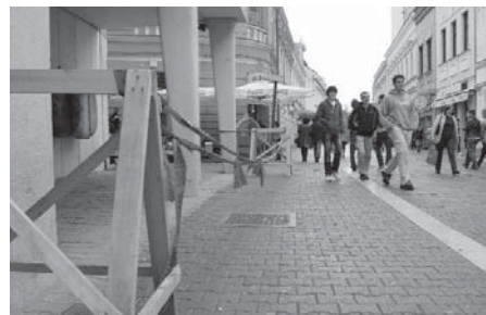
Црвена трака упозорава пролазнике на опасност
