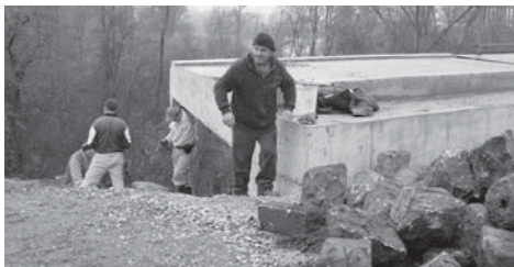
Изградња прилаза новом мосту на ријеци Сави
