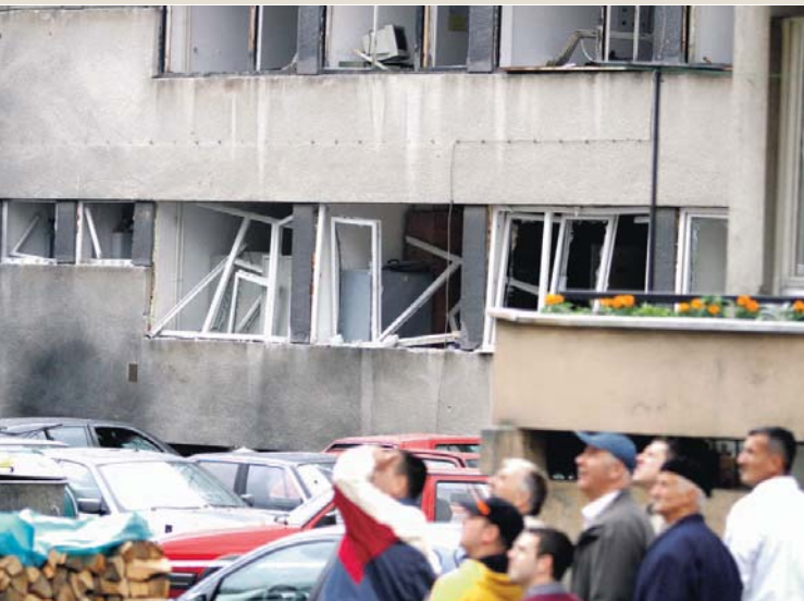
оштећене околне зграде и поразбијани прозори у кругу од 300 метара
