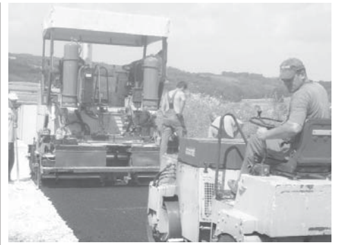
Асфалтирање пута у Чађавици
