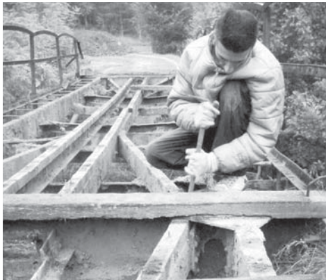
Уклањање конструкције старог моста
