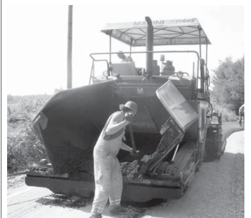
Асфалтирање пута у Градцу
