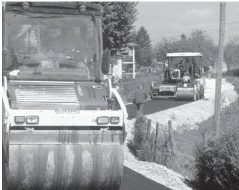
Асфалтирање пута кроз Бабановце
