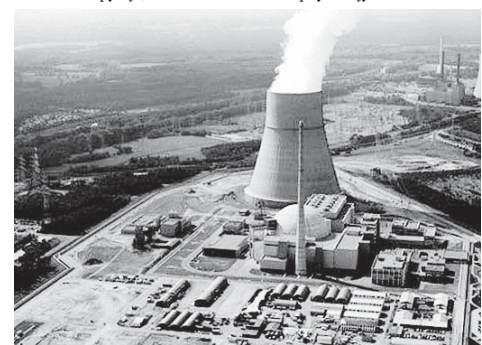
Нуклеарна електрана Бушер
