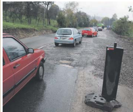
Постављене цијеви, на реду асфалтирања
