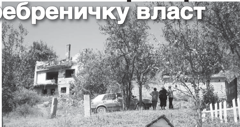
Порушене куће у селу Крњићи
