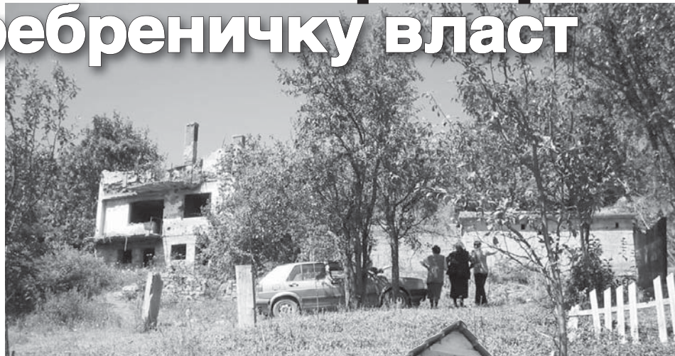
Порушене куће у селу Крњиће
